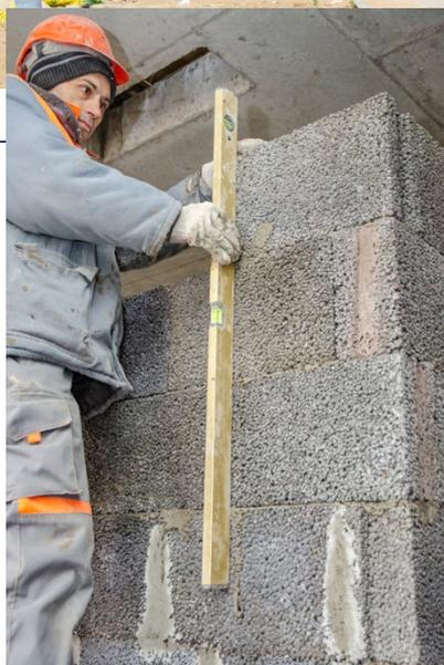
Технология работы со стеновыми блоками из керамзитобетона аналогична выполнению кладки из обычного кирпича или ячеистых блоков с тем исключением, что благодаря наличию пазо-гребневой системы вертикальные стыки между ними выполняются всухую, то есть без применения раствора, а при выпол-
